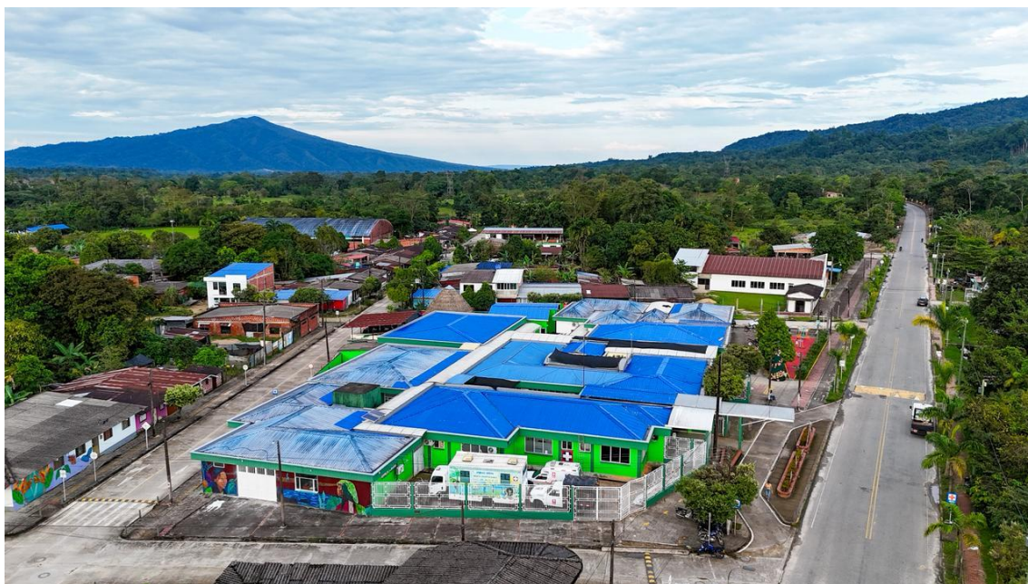
Ilustración 40 Toma aérea evidenciando cambio de cubierta HEC 2025
